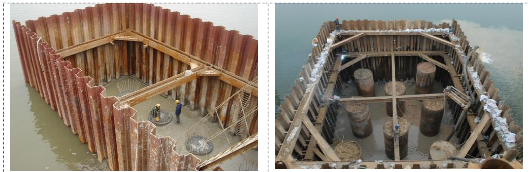
图 2.1-11 涉水桥墩钢围堰示意图
