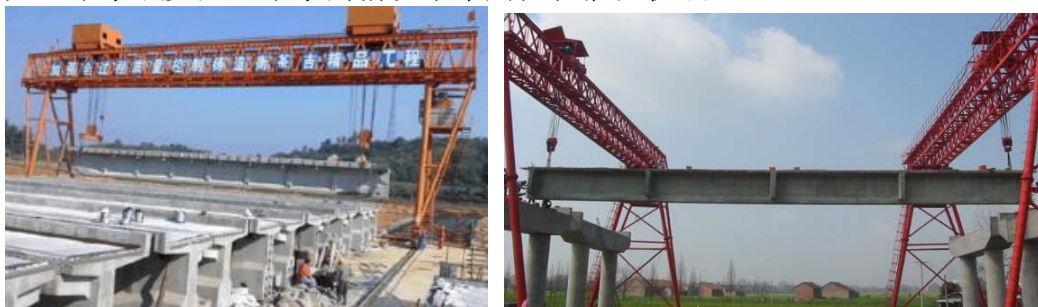
图 2.1-10 预制 T 梁施工示意图
