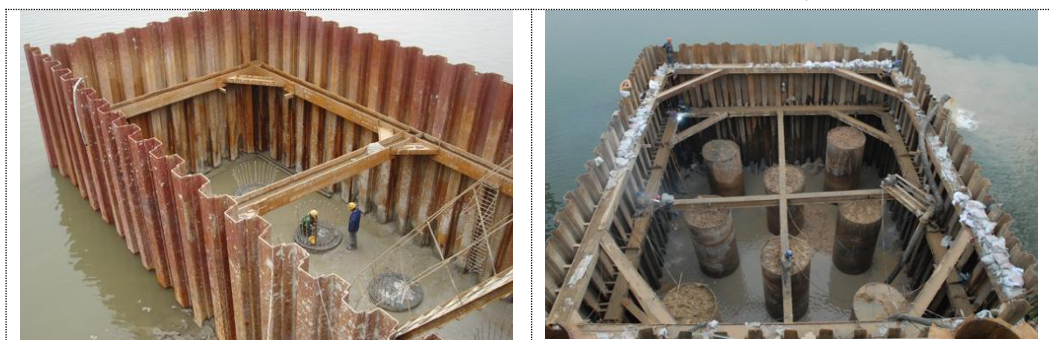
图 2.1-16 涉水桥墩钢围堰示意图
