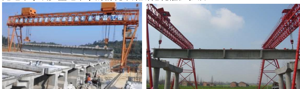
图 2.1-15 预制 T 梁施工示意图
